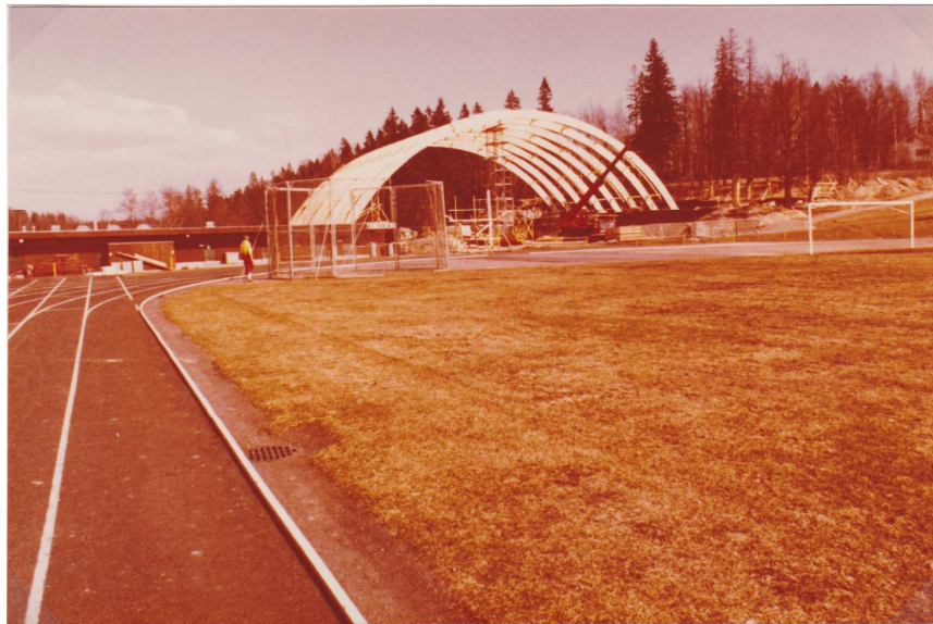
Laaksolahden jäähallin rakennusvaihe toukokuussa 1978 (kuva Kalevi Saukkonen)
